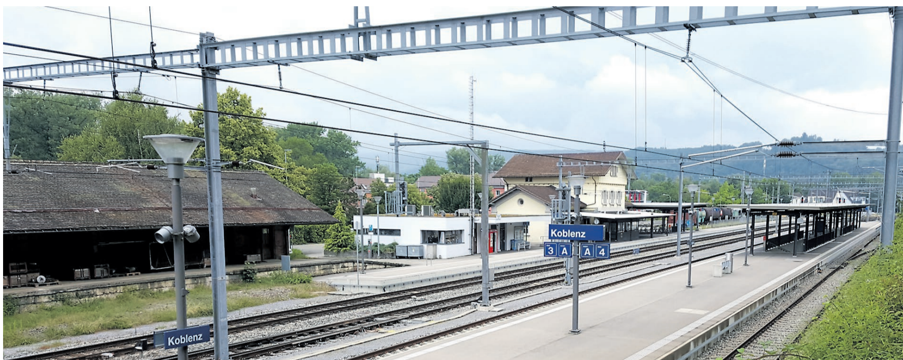
Die Arbeitsgemeinschaft «Pro Wiba» will sich weiter dafür einsetzen, dass am Bahnhof Koblenz möglichst bald wieder ein zwischen Winterthur und Basel verkehrender Interregio-Zug Halt macht. Die Signale vonseiten Kanton und Bund sind aber weiterhin negativ.
